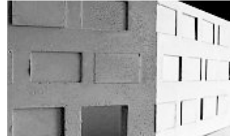
Betonmodell Fassadenstudie Brandhaus. Vor- und zurück-springende Wandfelder versteifen die freistehenden Betonfassaden und deuten zugleich Fenster als Referenzpunkte zur Orientierung an. – Bild: ARCHITEKTUR WERK und Atelier M Architekten
